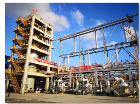
广汇LNG接收站项目
